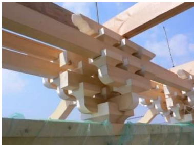
斗棋組立状況
