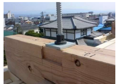
斗棋組立状況
