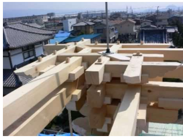
斗棋組立状況
